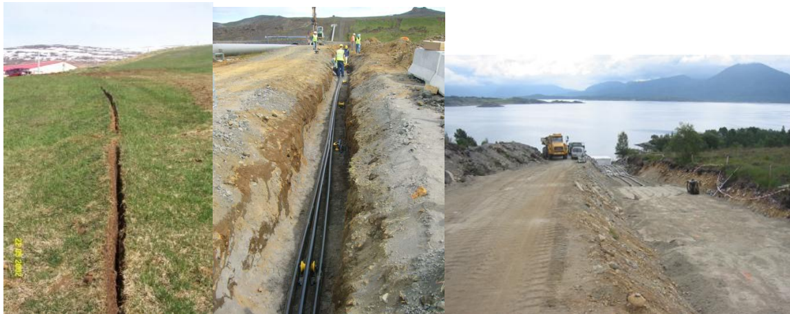
Mynd 15: Til vinstri lagning 11 kV strengs, fyrir miðju lagning 132 kV strengs og til hægri lagning 400 kV strengs.
